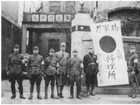
Ремонтная группа Сигэцугу перед заводом по ремонту армейских мечей.
